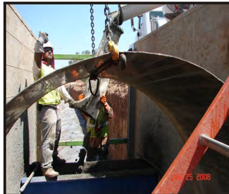
Pour the pipe.
